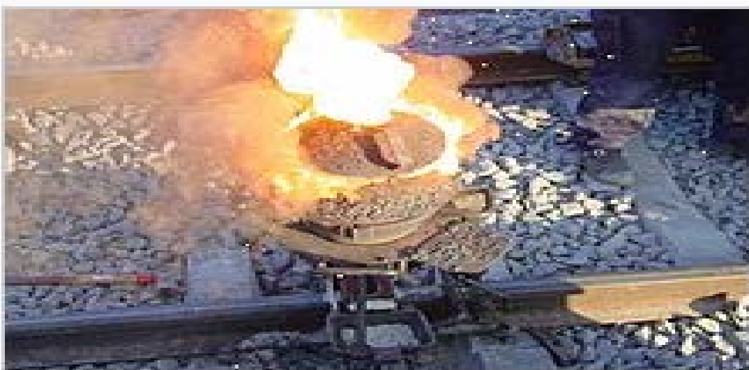
Termit qaynağı prosesi.
