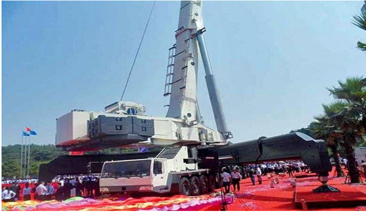
Şəkil33. ZACB - 01 dünyanın ən böyük kranı yükqaldırma qabiliyyəti 2000t.
