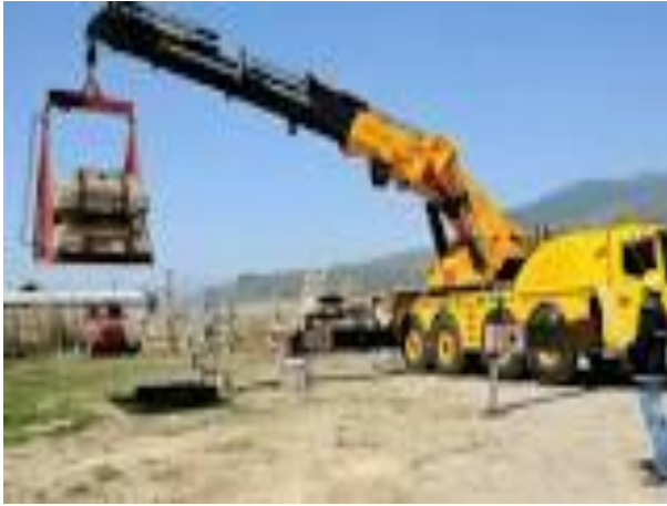
Şəkil 30. Kran manipulyator.
